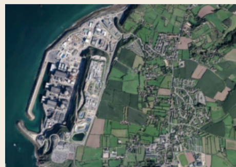
Figure 7. Le site de l'EPR à Flamanville (Cotentin), construit sur un pluton granitique et sur une zone poldérisée en rupture avec le bocage traditionnel encore présent. De nombreuses défaillances retardent le projet dont la livraison prévue pour 2012 n'est toujours pas d'actualité et dont le coût initial a été multiplié par quatre.
